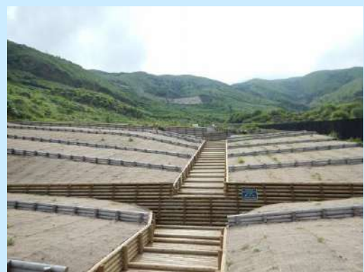
▲ 治山工事による被災箇所の復旧
