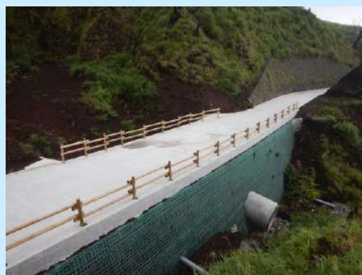
▲ 林道工事による被災箇所の復旧
